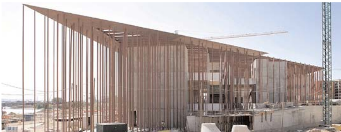
État des travaux du Pavillon de l'Espagne au mois d'août dernier
